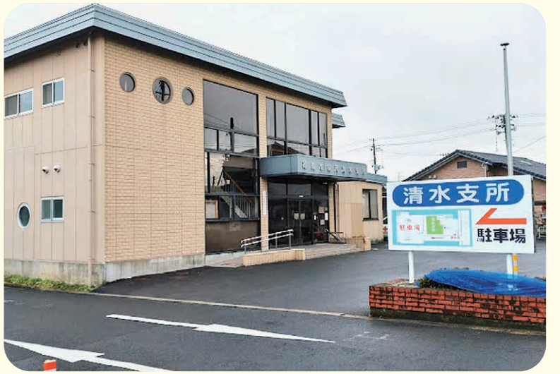
4月から解体工事が始まる旧清水支所
